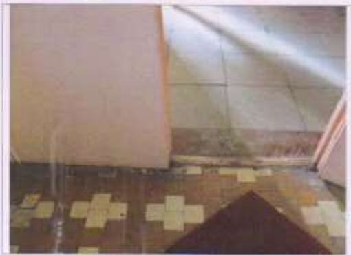
Фото №8 – Внутренняя входная дверь
