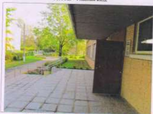
Фото №5 - Входящая площадка главного входа
