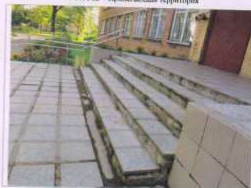
Фото №4 - Наружная лестница главного входа
