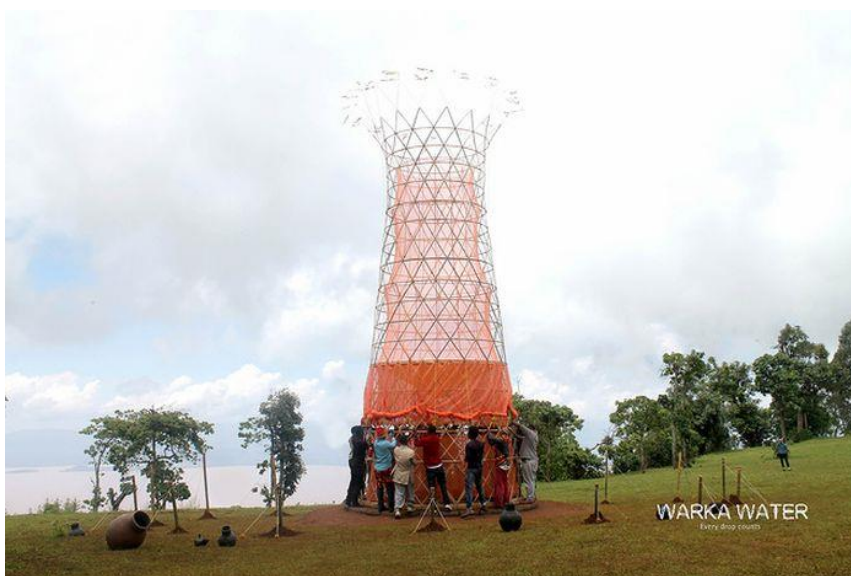
Рисунок 3 – Установка башни из бамбуковых ветвей [7]
